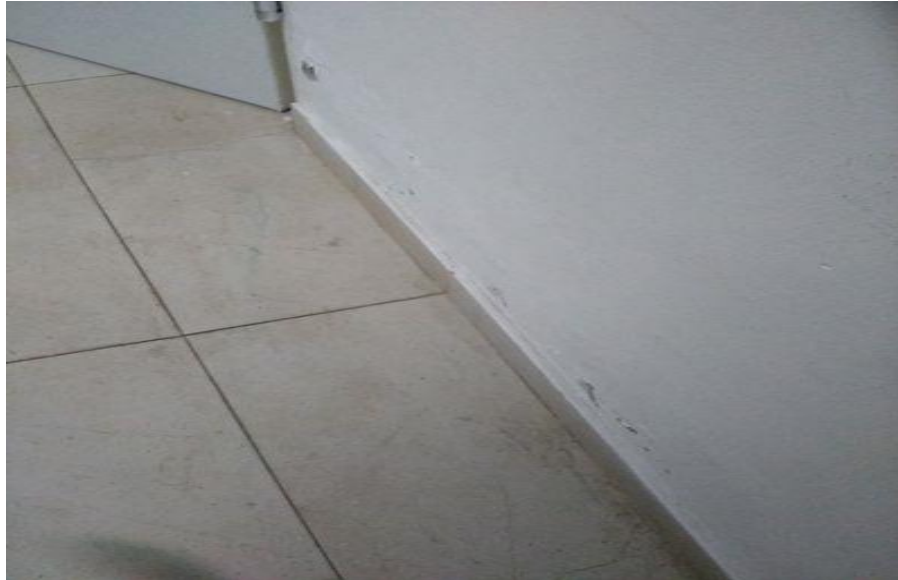
6.2. כללי : נמדדה לחות גבוה מעל 6% בניגוד לתקן במטבח בקיר המשותף לחדר הרחצה.
